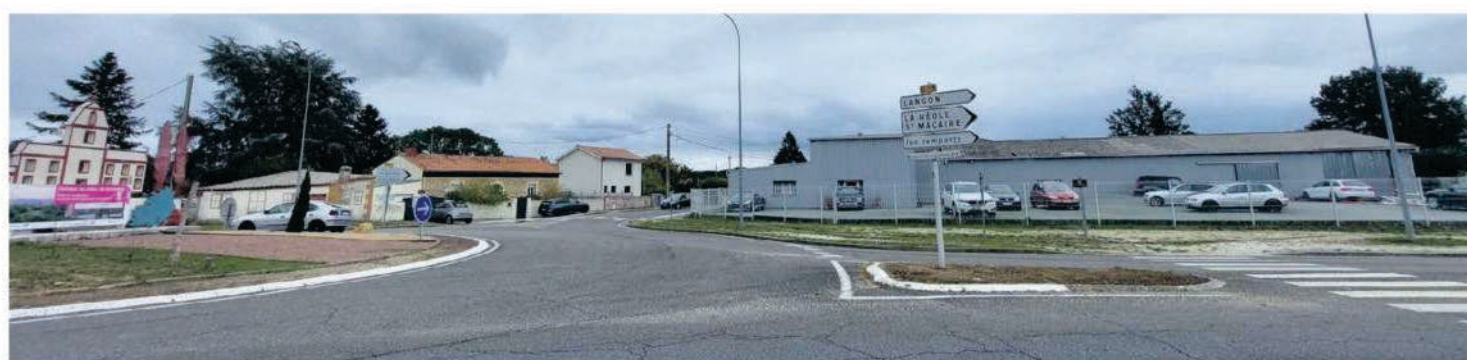
L'antenne-relais de 36 m devrait être implantée derrière le bâtiment de l'ex-garage au rond-point d'entrée de la ville de Saint-Maixant.
