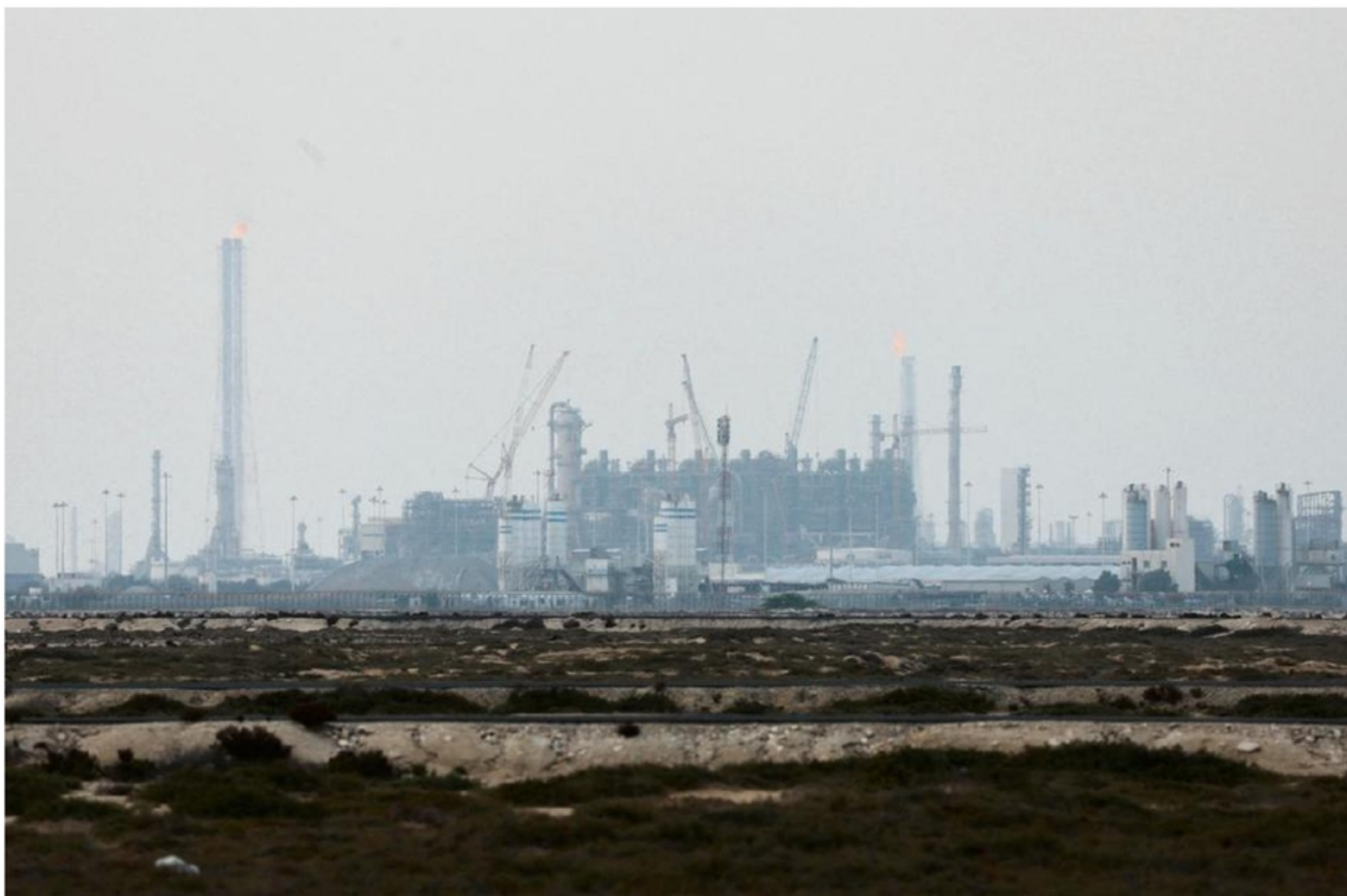
Installations de production de gaz naturel liquéfié de QatarEnergy, à Ras Laffan (Qatar), le 2 mars. REUTERS
