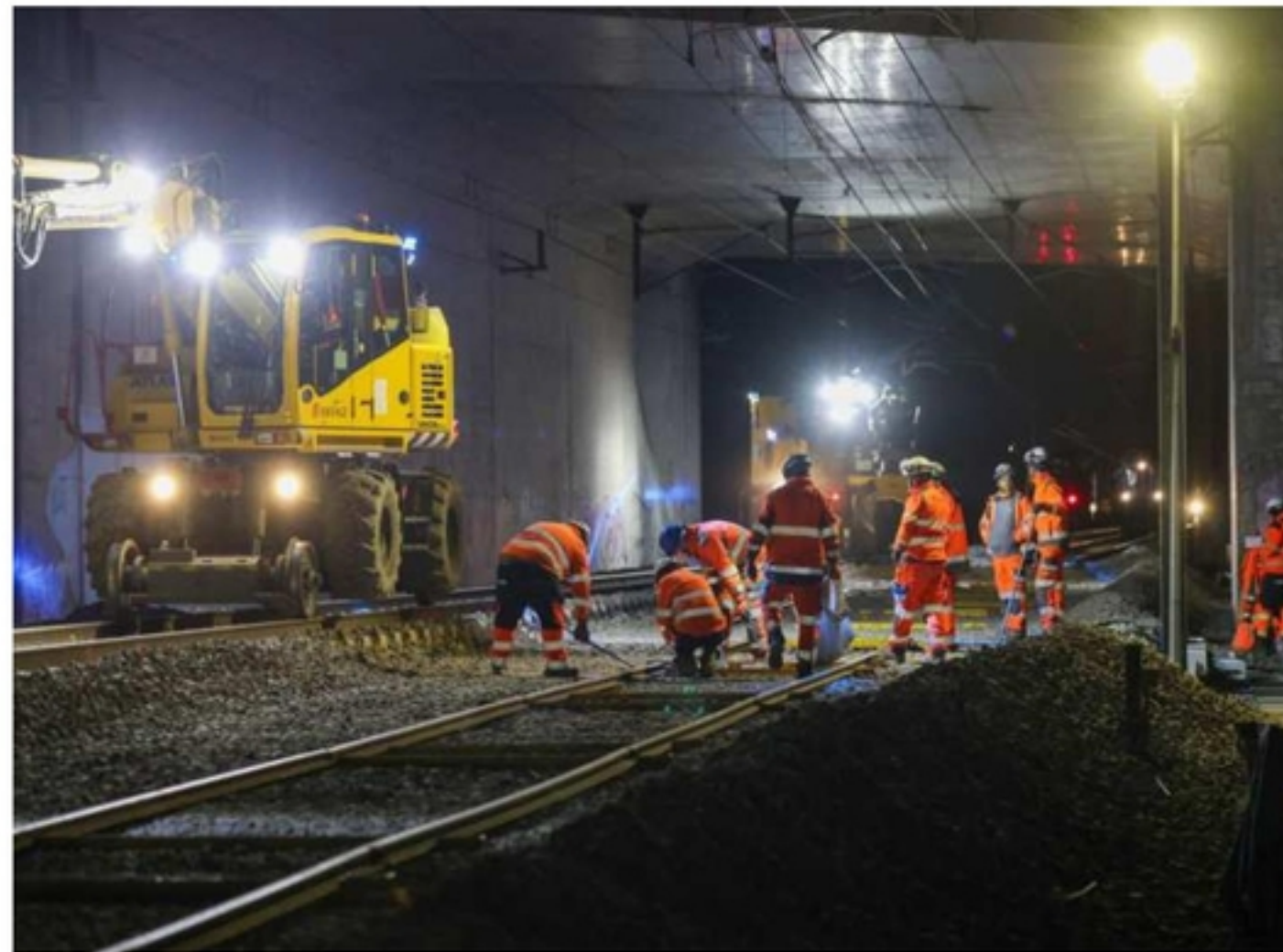
Alors que les certificats d'économie d'énergie étaient majoritairement réservés aux secteurs du logement et du bâtiment, leurs successeurs s'étendront aux transports, et notamment aux travaux sur les voies ferrées.
