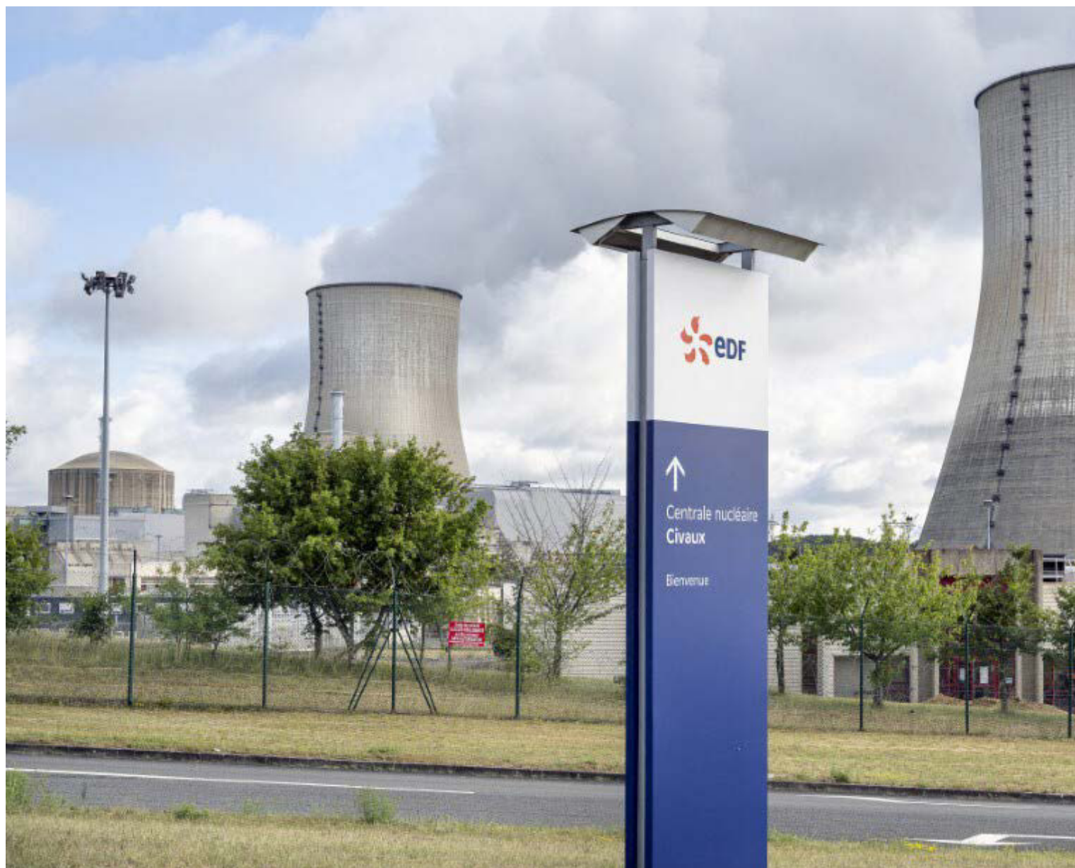
La corrosion sous contrainte provoque des microfissures sur les tuyauteries de refroidissement des réacteurs nucléaires. JEAN-FRANÇOIS FORT - AFP
