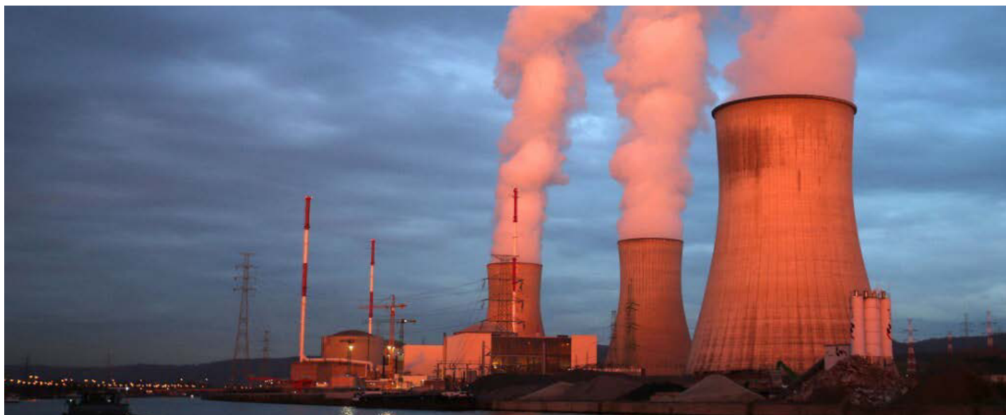
La centrale nucléaire de Tihange, en Belgique, compte trois réacteurs d'environ un gigawatt chacun. Tihange 1 est arrêté, Tihange 2 est en cours de démantèlement tandis que Tihange 3 va poursuivre son exploitation jusqu'en 2035, voire 2045. OLIVER BERG - AFP
