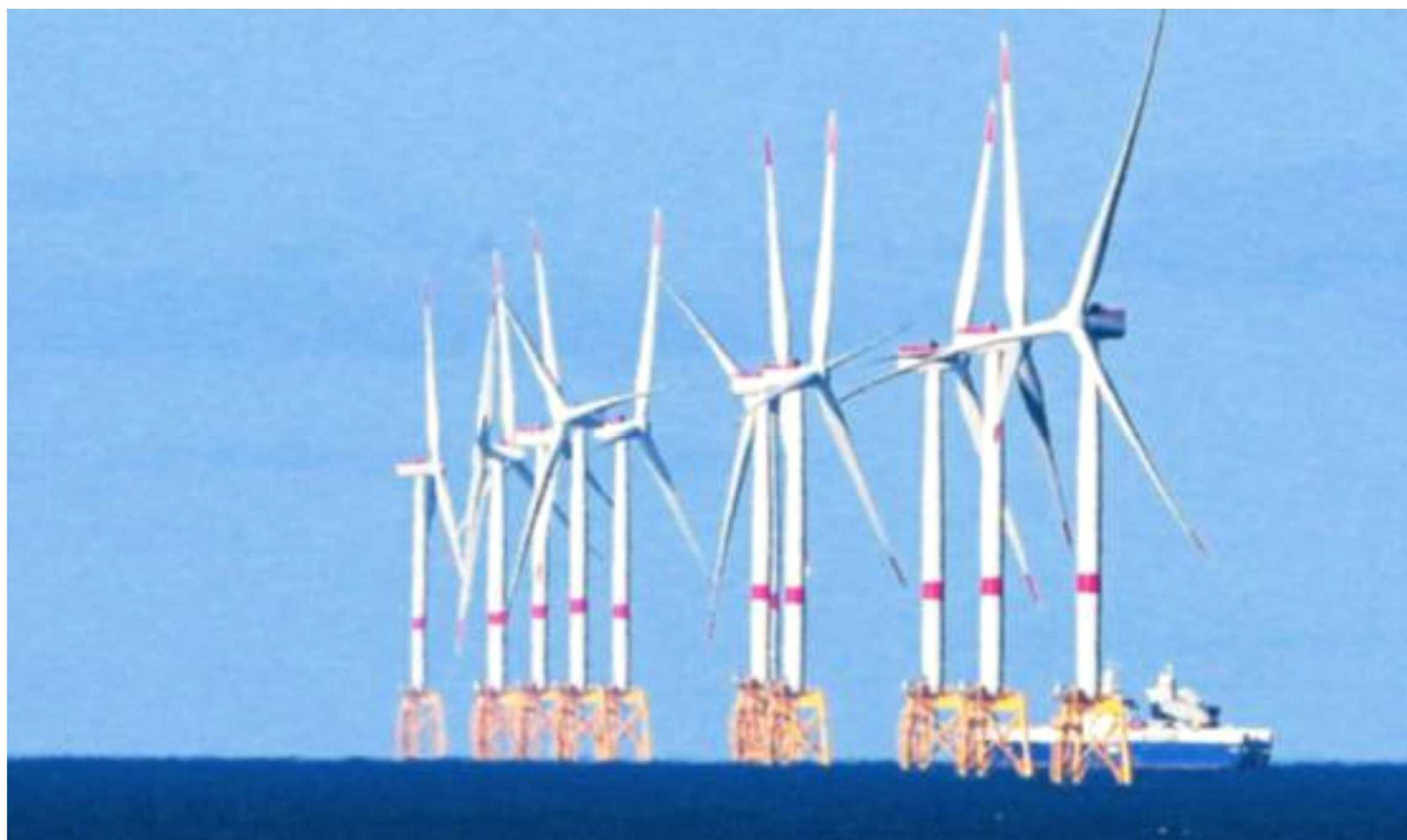
Le parc éolien offshore de la baie de Saint-Brieuc est le premier en service en Bretagne. Photo Lionel Le Saux
